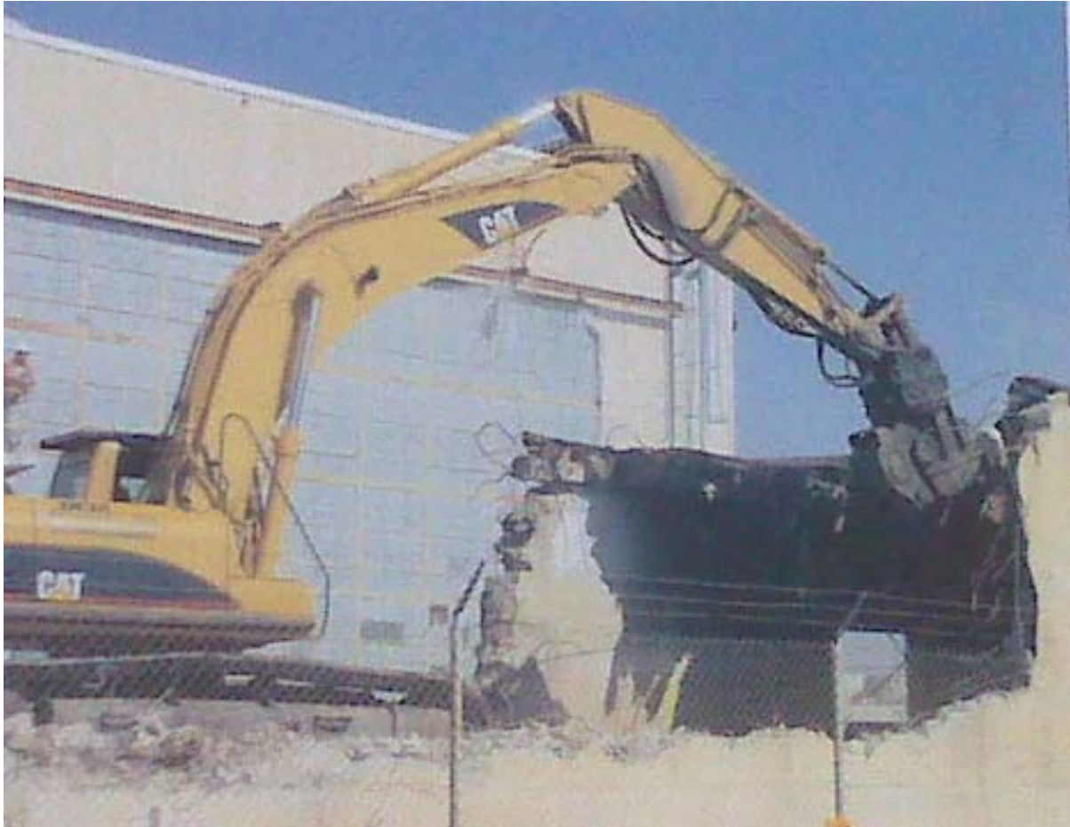
Figure A.10. Concrete Demolition (Pulverizer)
