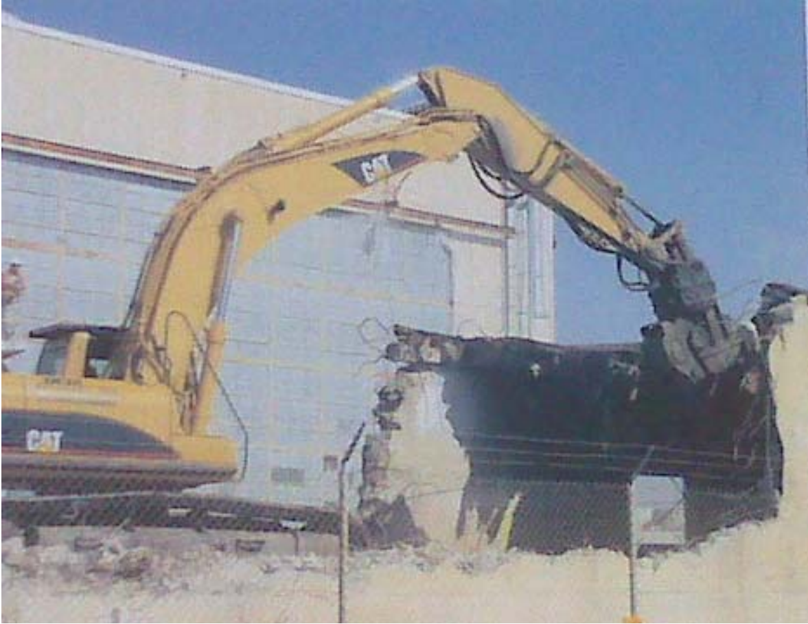
Figure A.10. Concrete Demolition (Pulverizer)
