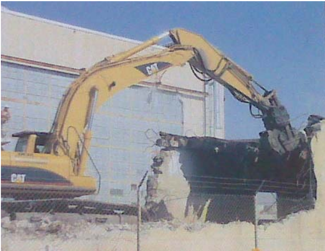
Figure A.9. Concrete Demolition (Pulverizer)
