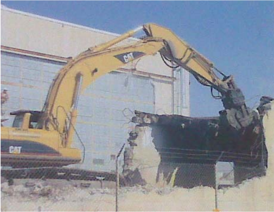
Figure A.9. Concrete Demolition (Pulverizer)
