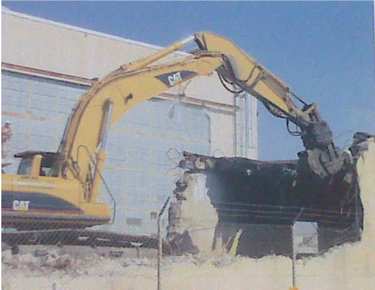
Figure A.10. Concrete Demolition (Pulverizer)
